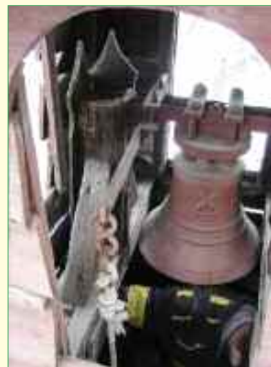
Úprava zvonu na automatické zvonění
