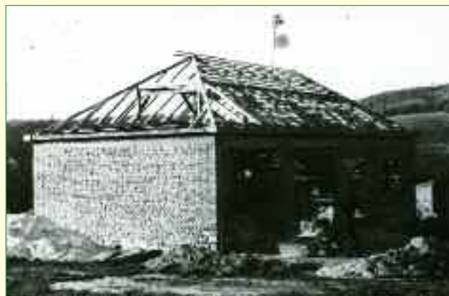
Pokračování výstavby hasičské zbrojnice
