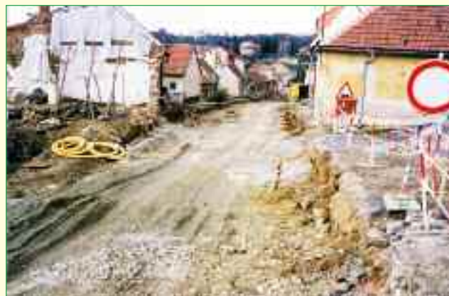
Rekonstrukce silnice Horní konec
