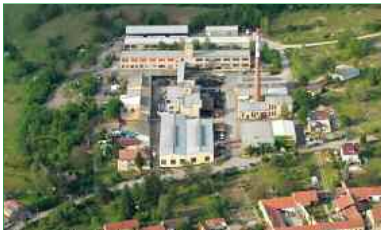
Dům č. p. 104 – Obnova
