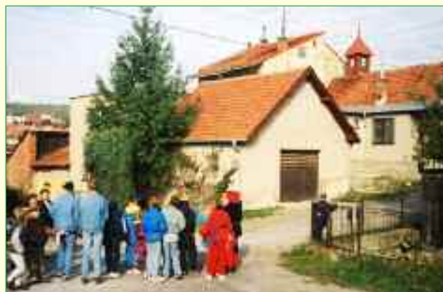
Původní skladiště hasičské zbrojnice po opravě - Malá Strana
