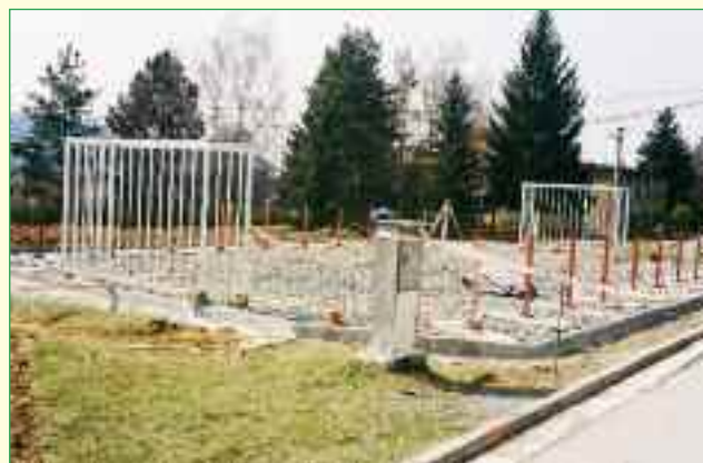
Multifunkční hřiště na Bukové
