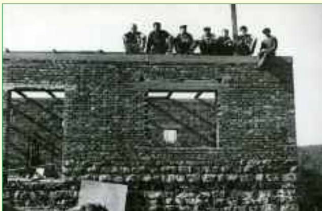
Začátek výstavby hasičské zbrojnice rok 1966
