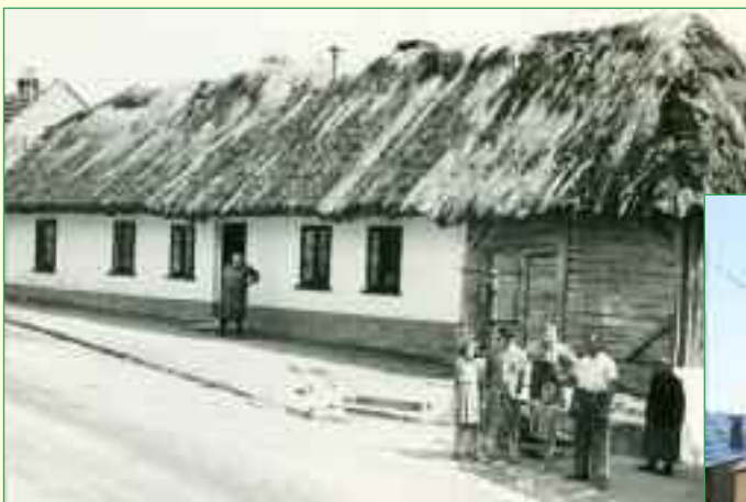
Na domě č. p. 23, nyní Opletalovi, byla až do roku 1956 došková střecha. Dům je starý asi 350 let.
