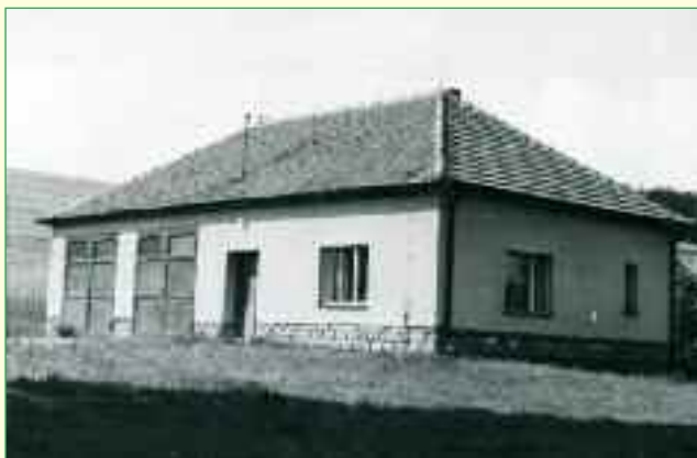
Dokončená budova hasičské zbrojnice rok 1968
