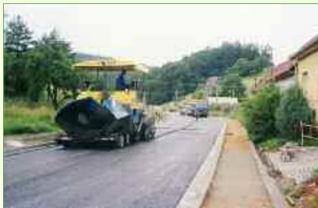
Rekonstrukce silnice Dolní konec
