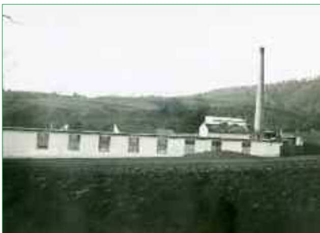
Dům č. p. 104 – Obnova
