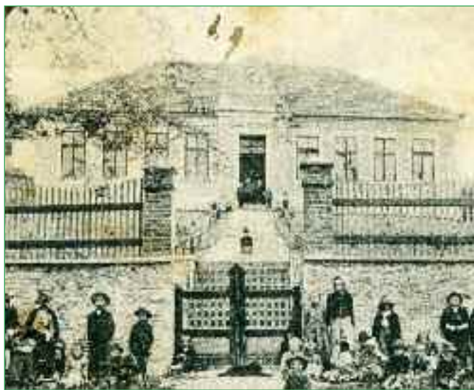
Budov staré školy č. p. 76
