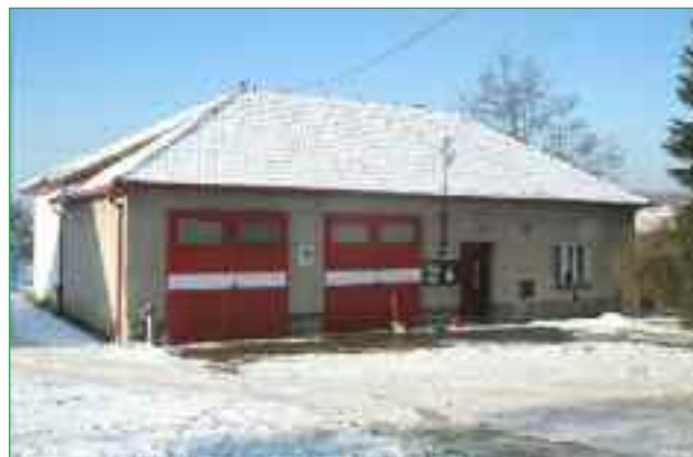
Hasičská zbrojnice č. p. 165 v roce 2009
