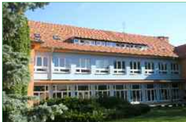
Budova ZŠ po opravě v roce 2007
