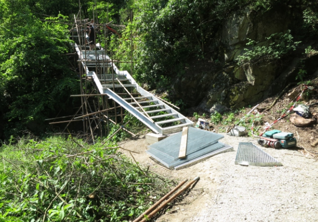
Stavba schodů na červené turistické značce.
